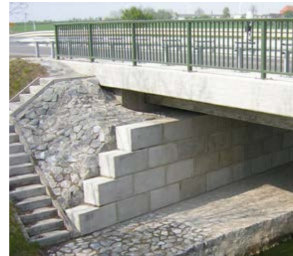
Brückenwiderlager über einen Flusslauf Deutschland | Sanierung der zweispurigen Landesstraße L71 bei Lust – Überbrückung eines kleinen Flußlaufes – Realisierung des mit Fortrac bewehrten Brückenwiderlagers mit großen, rechteckigen Betonblocksteinen – 90° Neigung.
