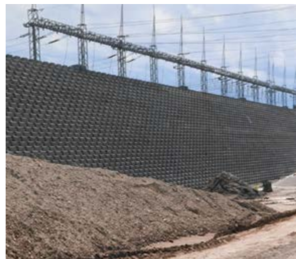
Stützwand für ein Kraftwerk in Temelin Tschechien | Sehr weiche Bodenverhältnisse – Fortrac-Bewehrte-Erde mit Beton-Hohlkammersteinen und zusätzlicher Vertikaldrainage – Realisierung einer Höhe von bis zu 7 m und einer Neigung von 66°.
