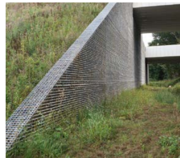
Doppelbrückenwiderlager Autobahn A74 Niederlande | Großprojekt bei Venlo mit u. a. zwei Autobahnbrücken direkt nebeneinander – Höhe der Brückenwiderlager 11 m und 9 m – Schnelle Realisierung auf sehr weichem Untergrund – System wurde vorbelastet und zeitversetzt installiert – Ankerstabsystem.
