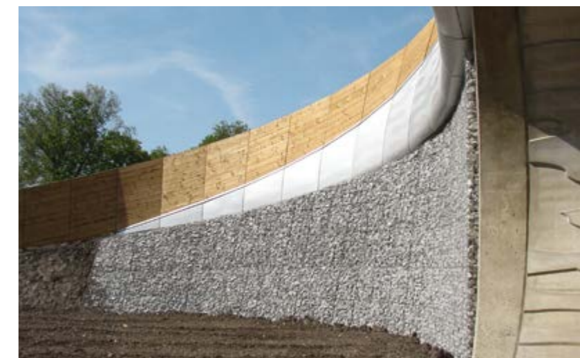
Moderne Wildbrücke über die Autobahn A2 Niederlande | Grünbrücke bzw. Wildbrücke über die Autobahn A2 – Geschwungene Anrampung mit architektonisch modernem Aufsatz – Umsetzung der Fortrac- Bewehrten-Erde in Kombination mit einer Halbgabionenverkleidung – Höhe ca. 8 m.
