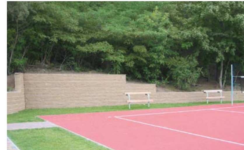
Sport- und Freizeitflächen in Waren, Müritz Deutschland | Gestaltung von Sport-, Freizeit und Parkflächen für eine neue Jugendherberge in Waren (Müritz) – Realisierung mit Hohlkammersteinen – Mauer mit 90° Neigung – Gerade und geschwungene Mauerabschnitte in unterschiedlichen Höhen.
