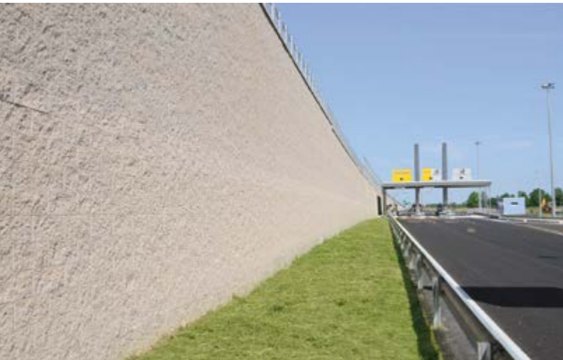
Anrampung für neue Venedig-Umgehungsstraße Italien | Modernes Hohlkammerstein-Facing in landschaftlich passender Farbe – Aufbau mit betonstabilisierter Erde – Einsatz alkalibeständiger Fortrac Geogitter aus PVA – Installation ohne Rückumschlag – Bauwerkshöhe ca. 10 m mit 90° Neigung.
