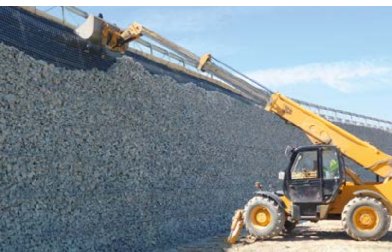
Anrampung für neue Umgehungsautobahn Rumänien | 11 m hohe u. 200 m lange Anrampung (A4 zw. Konstanz u. Poiana) – Ankerstabsystem – Angepasste Maschenweite des Stahlgitters – Schneller Baufortschritt u. a. durch unkomplizierte Befüllung mithilfe einfacher Baugeräte u. natürlichem Schüttgut ( \varnothing 140 mm).
