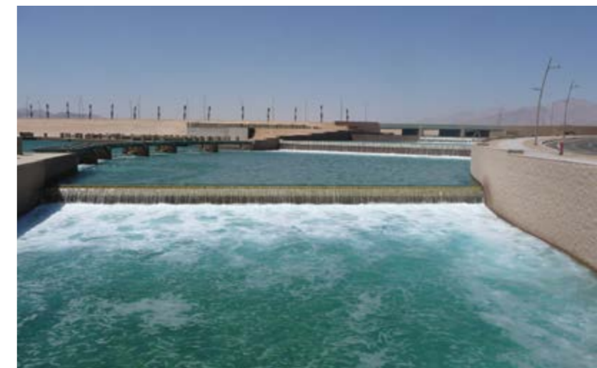
Lagunenlandschaft Ayla Oasis Jordanien | 4.300.000 m 2 große Oasenlandschaft – 15 km Strand- und Uferpromenade mit Fortrac-Bewehrter-Erde und Hohlkammersteinen – Auslegung für Erdbebenlasten gemäß Eurocode 8 und einen plötzlichen Wasserspiegelabfall vor den Wänden.
