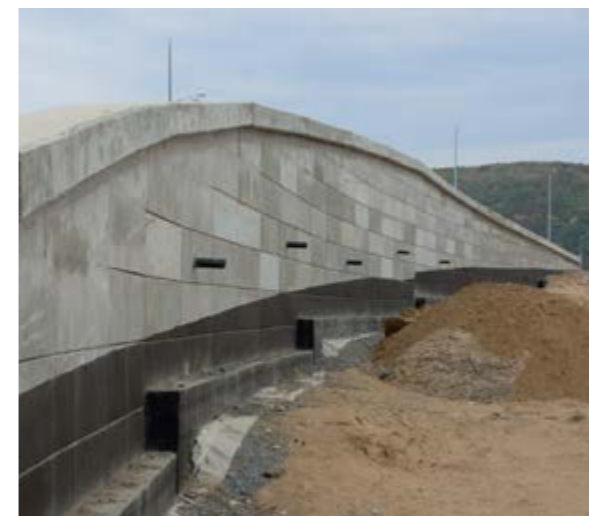
Mautstraße M11, Moskau - St. Petersburg Russland | Hochgeschwindigkeitsautobahn mit über 60 KBE-Konstruktionen – Realisierung mehrerer Brückenwiderlager – Bewehrte Erdkörper mit alkalibeständigen Fortrac Geogittern (PVA) und Stahlbetonblöcken mit Hohlkammern als Frontelement – Neigung 90°.
