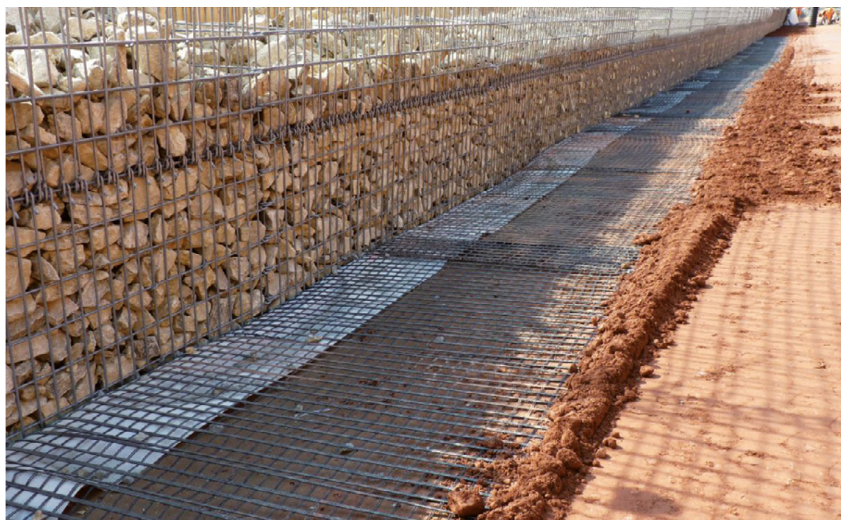
Gekoppelde schanskorf muur (A3 snelweg nabij Haseltal, Duitsland)
