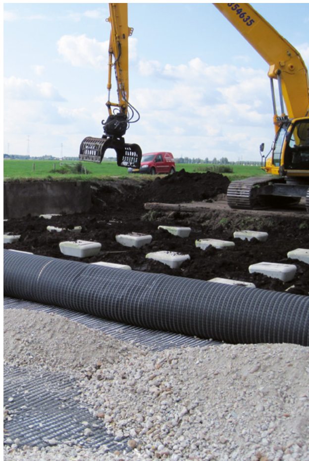
Geotextiel wapening geïnstalleerd op paalfundering (N 210; Nederland)
