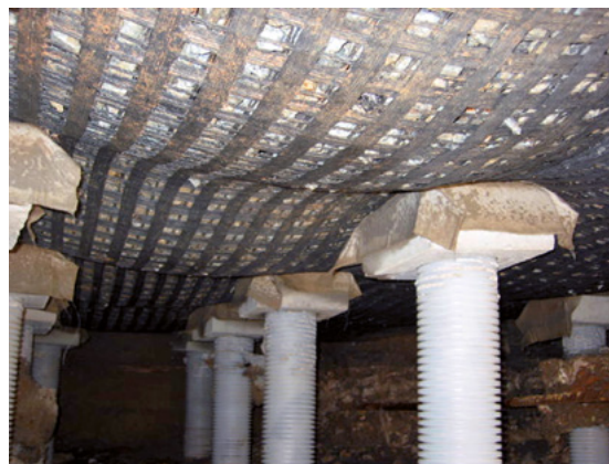
Membraanefect bij toepassing van paalmatrasen (Spoorweg Bidor-Rawang, Maleisië)
