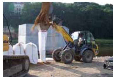
Mechanisch vullen door middel van trechter, graafmachine
