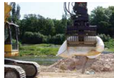
Installatie met behulp van een graafmachine
