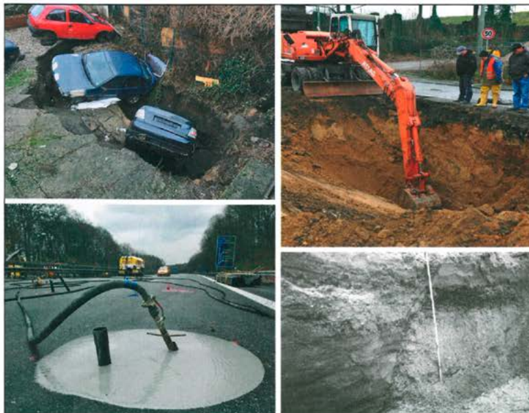
2 Typische durch Bergbau bedingte Tagesbrüche im Ruhrgebiet (eigene Quellen) und ein Versprung (unten rechts, Scherbeck et al, 2000)
