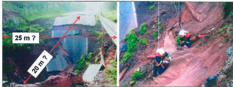
10 B 180 Eisleben: der Morgen nach dem Einbruch (links) und Bergung der Geogitter zum Testen (rechts) Quelle: HUESKER
