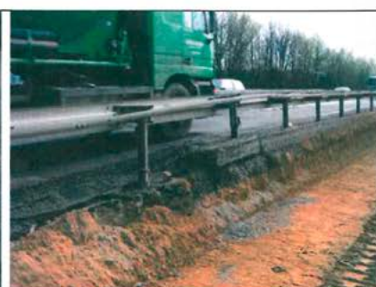
11 BABA57 bei Asdonkshof: Übersicht li., typischer Versatz nach Freilegung Mitte, frühere Sanierungsweise mit Aushub und darauffolgender Erhöhung re. Kirsch & Placzek, 2009, modifiziert
