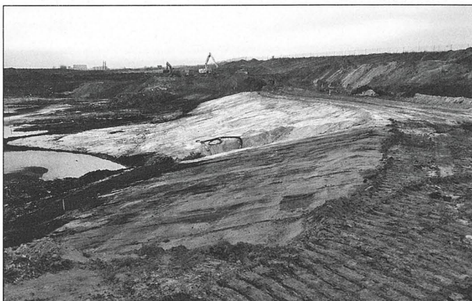
Abbildung 6: Profilierung der Böschungen auf 1:3
