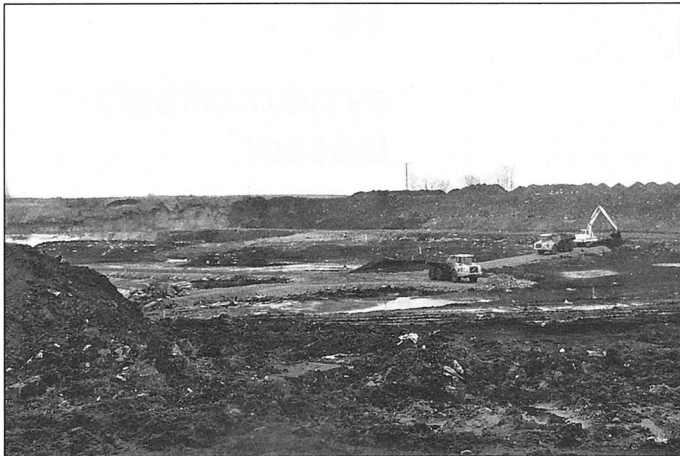
Abbildung 8: Einbau der Stützdämme.
