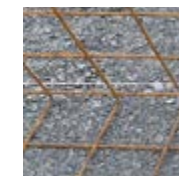
Verloren of tijdelijke bekisting voor passieve facing
