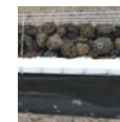
Geluidsabsorbe- rende laag (voor geluidsbeheersing)
