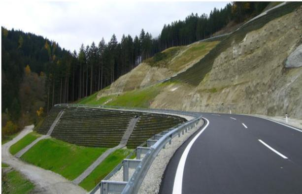
Abbildung 8 Teilansicht KBE-Böschungen im Bereich der Kehren, zur Verkehrsfreigabe, Sommer 2008
