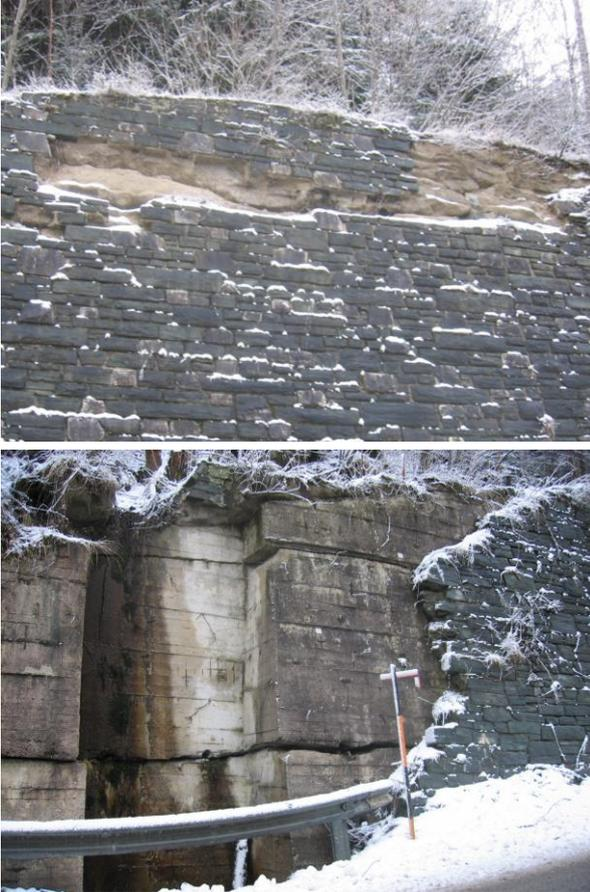
Abbildung 2 Schäden an Stützwänden der existierenden „alten“ Trasse
