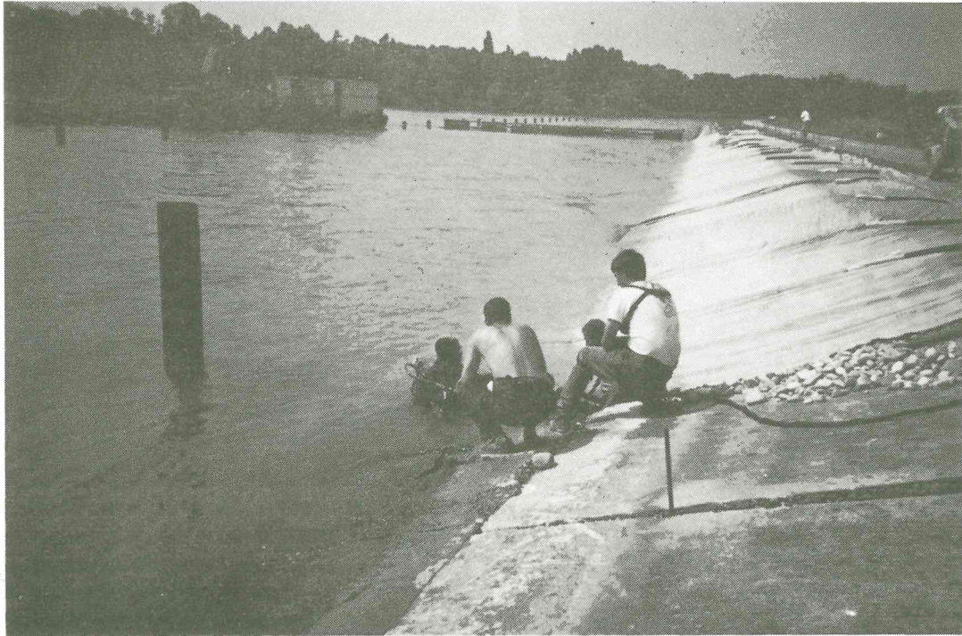
Le remplissage des matelas se fait sous la conduite des plongeurs / The filling of the mattresses is being checked by divers
