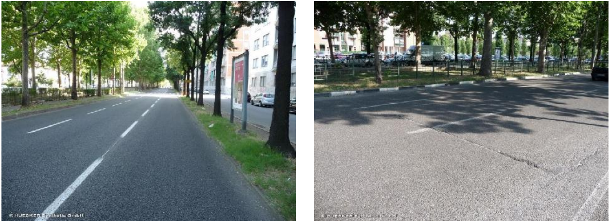
Figure 10 : Comparaison du Corso Giovanni Agnelli à Turin (Italie) 4 ans après la réhabilitation entre la section renforcée (à gauche) et la section non renforcée (à droite)
