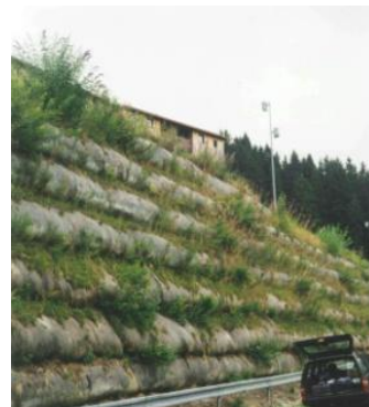
Figure 1. Mur construit en 1977 à Prapoutel les Sept Laux – (+1350 m) Alpes (Nappes de Stablenka® 200 - 33 ans après le parement additionnel n'ayant jamais été construit).
