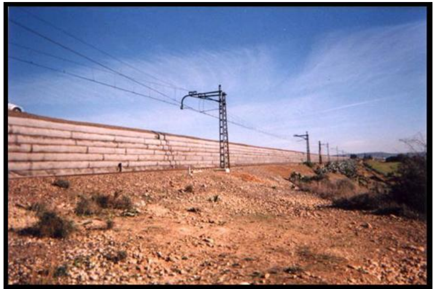
Figure 12 : Massif renforcé par géogrilles - dédoublement de la ligne ferroviaire Meknès-Fès
