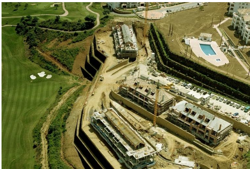
Figure 5 : Vue d'ensemble du projet, Mijas, Espagne
