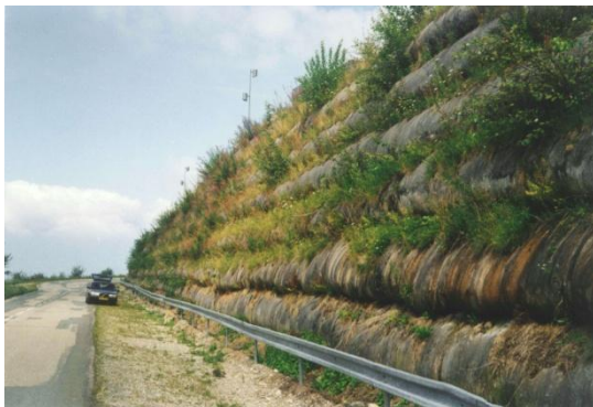
Figure 1. Mur construit en 1977 à Prapoutel les Sept Laux – (+1350 m) Alpes (Nappes de Stablenka® 200 - 33 ans après le parement additionnel n'ayant jamais été construit).
