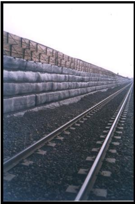
Figure 12 : Massif renforcé par géogrilles - dédoublement de la ligne ferroviaire Meknès-Fès
