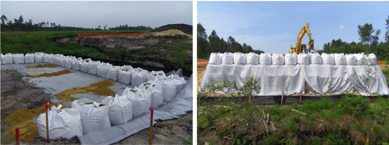
Figure 11. Mise en œuvre.
