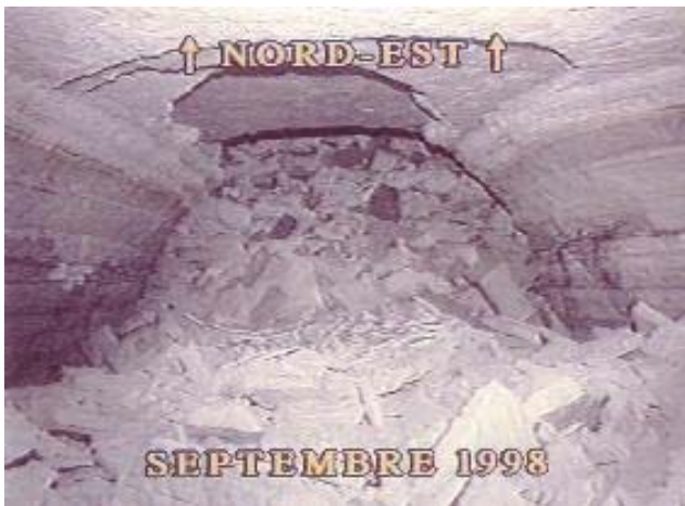
Figure 2. Vue par vidéo-scopie d'un fontis en carrière
