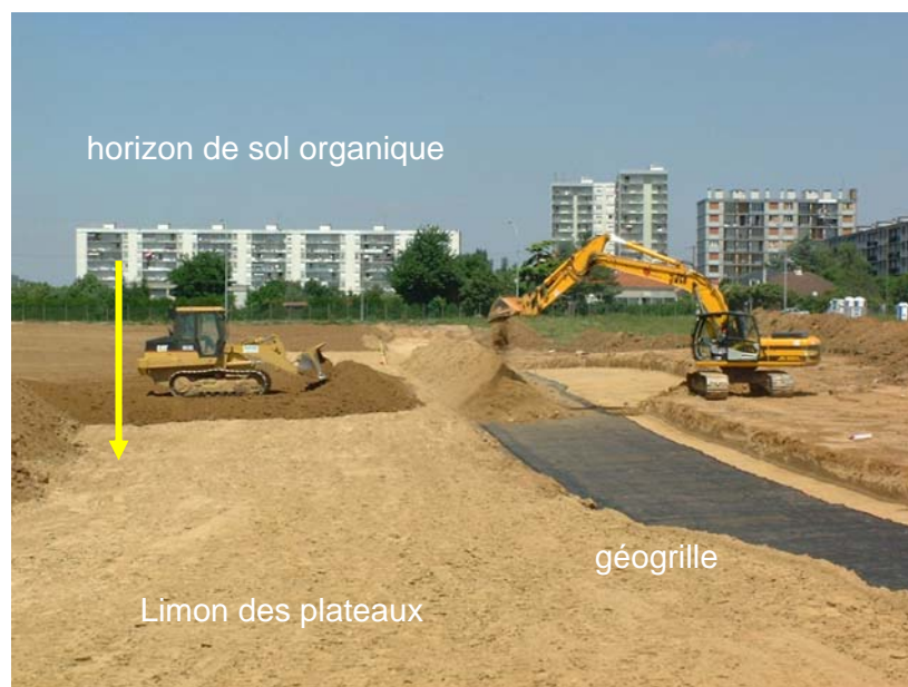
Figure 12. Remise en place des sols
