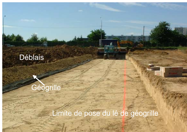
Figure 10. Fond de forme et pose de la géogridde avec chevauchement
